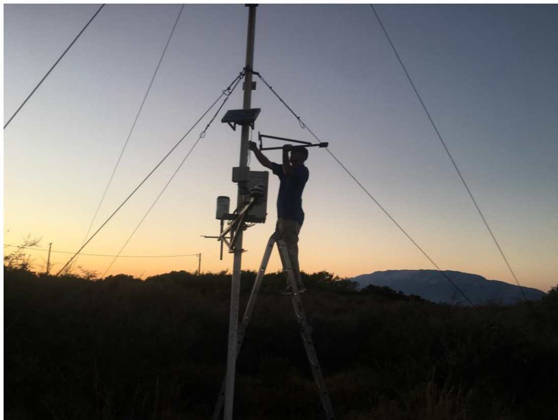
Εικόνα 1.2-2: Απο τις τεχνικές εργασίες στον σταθμό ΖΚΤ-3 στις 10/7/2022.
