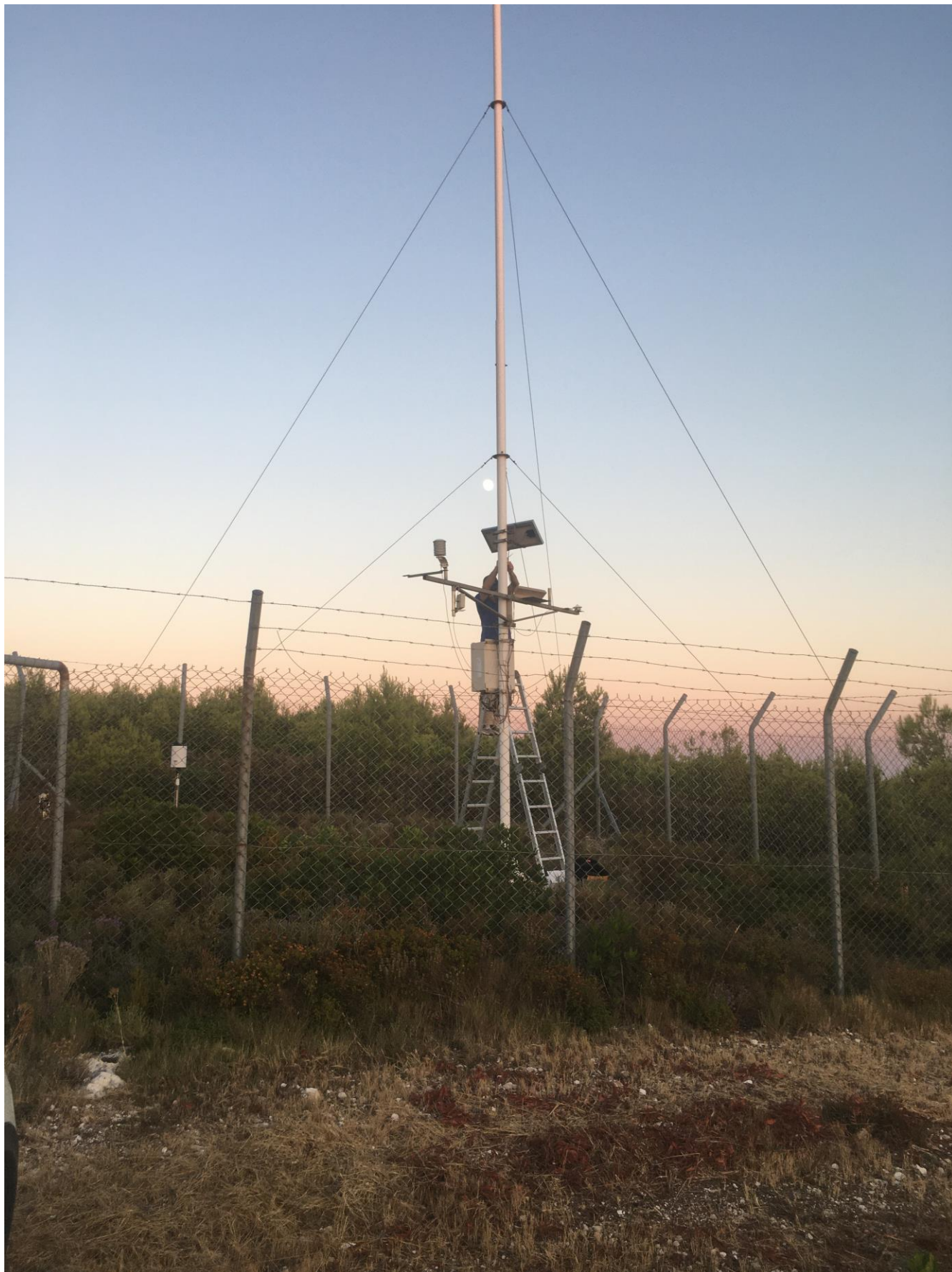
Εικόνα 1.2-10: Απο τις τεχνικές εργασίες στον σταθμό ΖΚΤ-1 στις 11/7/2022.
