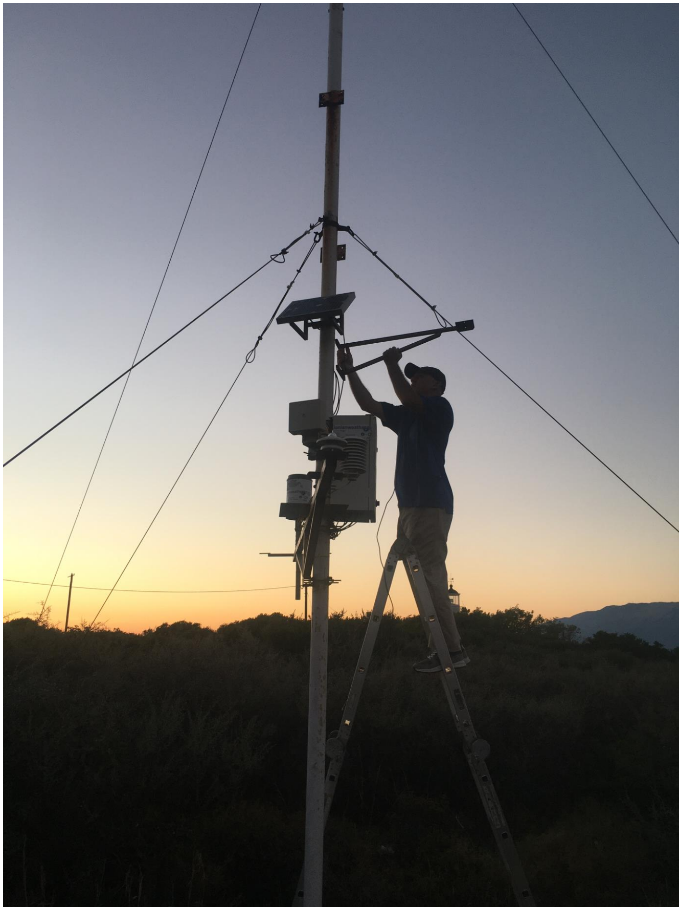
Εικόνα 1.2-3: Απο τις τεχνικές εργασίες στον σταθμό ΖΚΤ-3 στις 10/7/2022.
