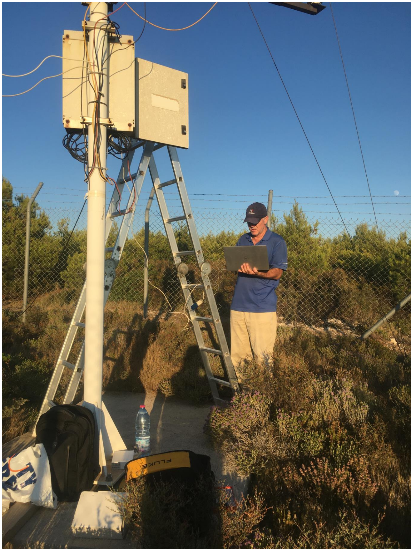
Εικόνα 1.2-8: Απο τις τεχνικές εργασίες στον σταθμό ΖΚΤ-1 στις 11/7/2022.
