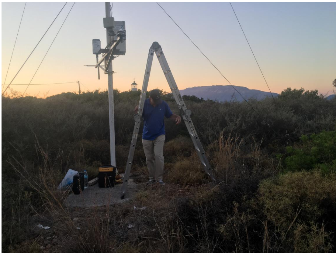
Εικόνα 1.2-1: Απο τις τεχνικές εργασίες στον σταθμό ΖΚΤ-3 στις 10/7/2022.
