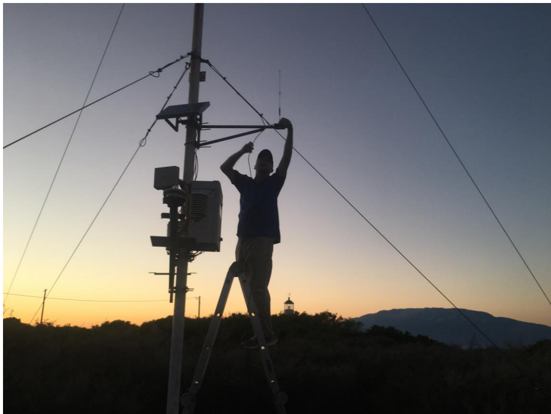
Εικόνα 1.2-4: Απο τις τεχνικές εργασίες στον σταθμό ΖΚΤ-3 στις 10/7/2022.
