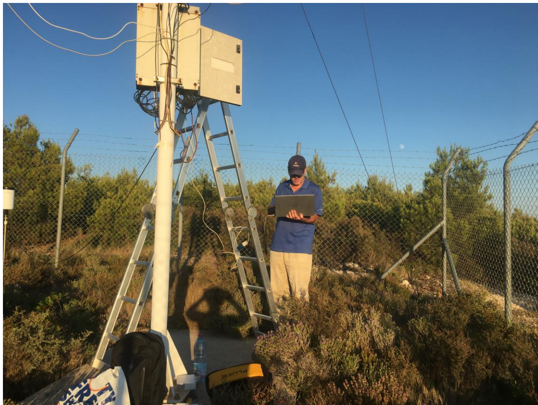
Εικόνα 1.2-8: Απο τις τεχνικές εργασίες στον σταθμό ΖΚΤ-1 στις 11/7/2022.
