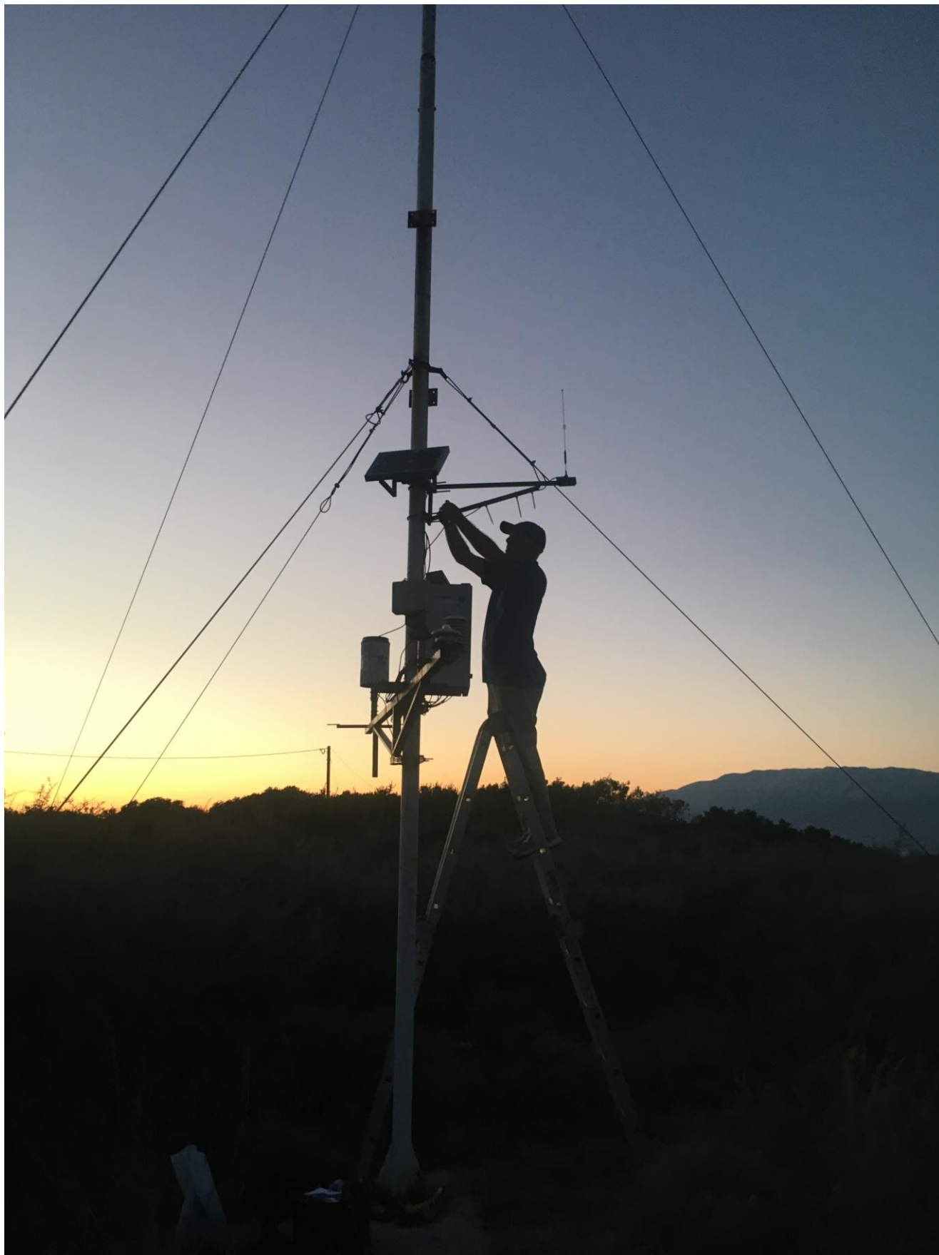
Εικόνα 1.2-6: Απο τις τεχνικές εργασίες στον σταθμό ΖΚΤ-3 στις 10/7/2022.
