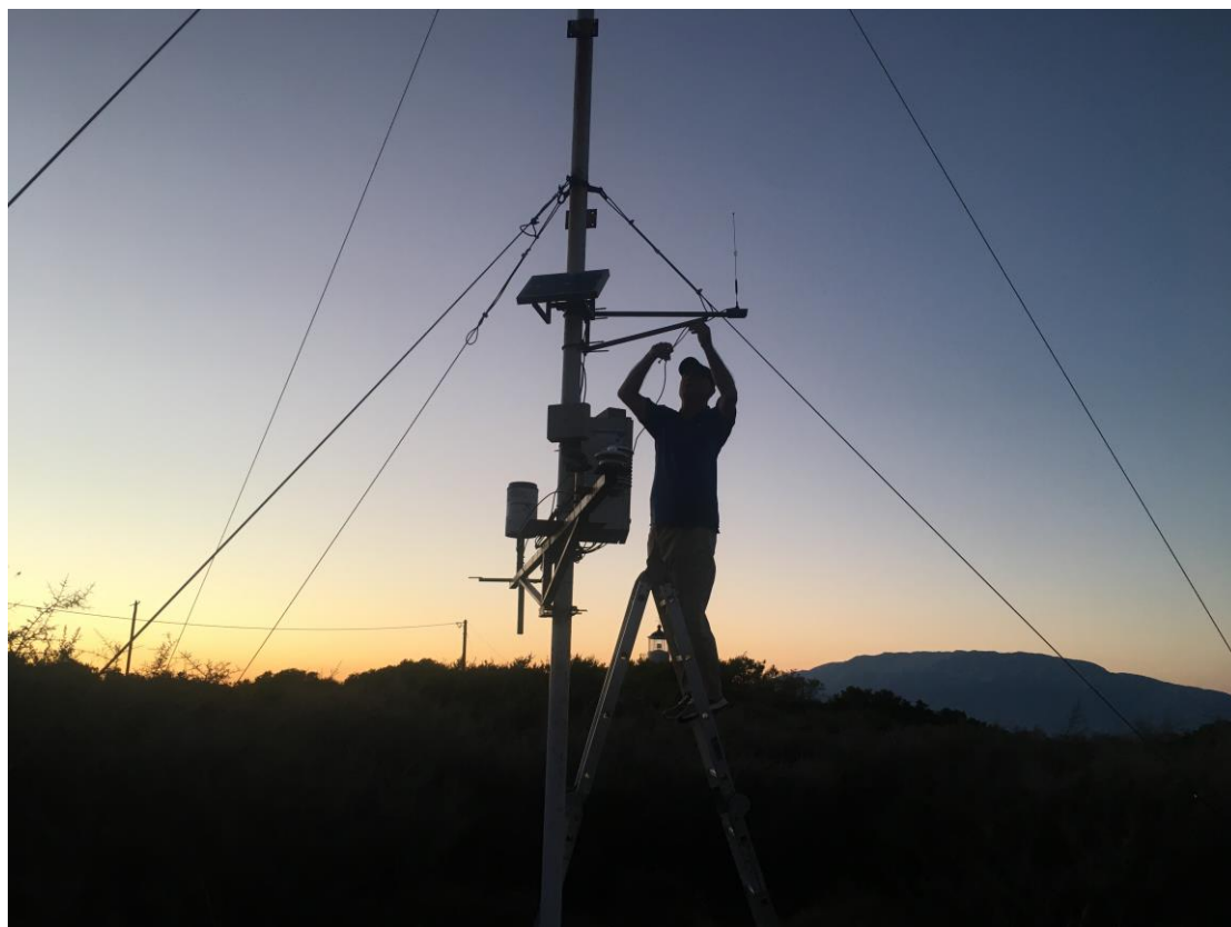
Εικόνα 1.2-5: Απο τις τεχνικές εργασίες στον σταθμό ΖΚΤ-3 στις 10/7/2022.
